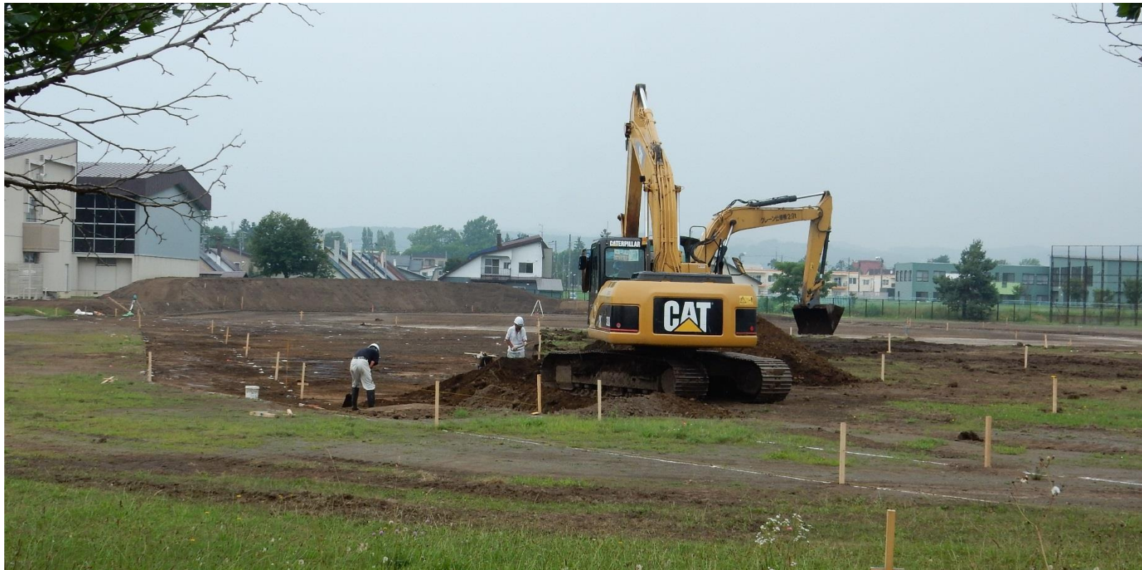
グラウンド造成工事の中本土建(株)さん（写真は7月末）
